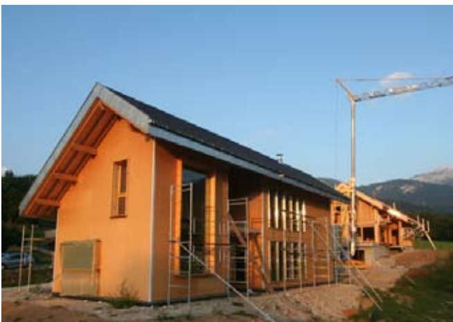
Chantier des 2 maisons à Bellecombe en Bauges
