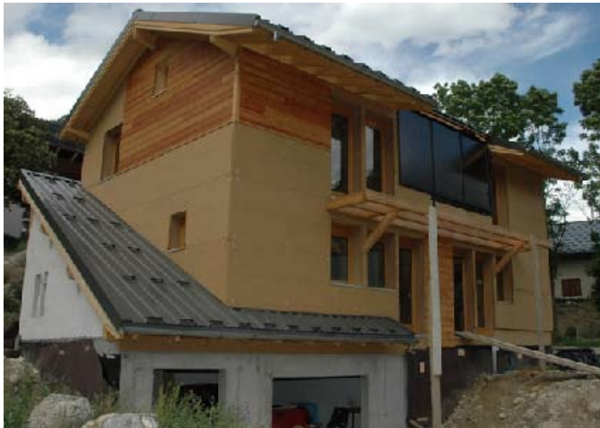
Maison en construction à Modane
