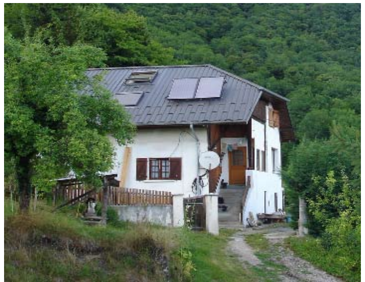
Maison en cours de rénovation thermique à Fréterive
